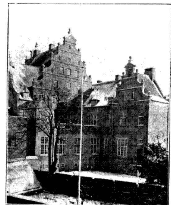
Vendsyssel Bank set fra Jernbanegade.
